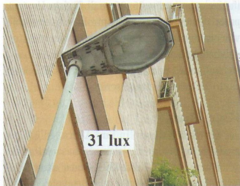
Fig 2. Lampione con vetro piano nuovo.
