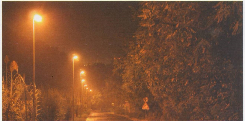
Fig 3. Impianto con coppe curve opache.
