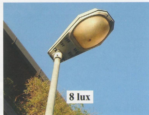
Fig 1. Lampione con coppa sporca.
